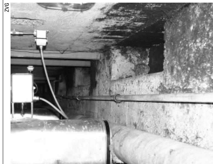
Der Kellerraum im Fabrikgebäude bei Wimmis
